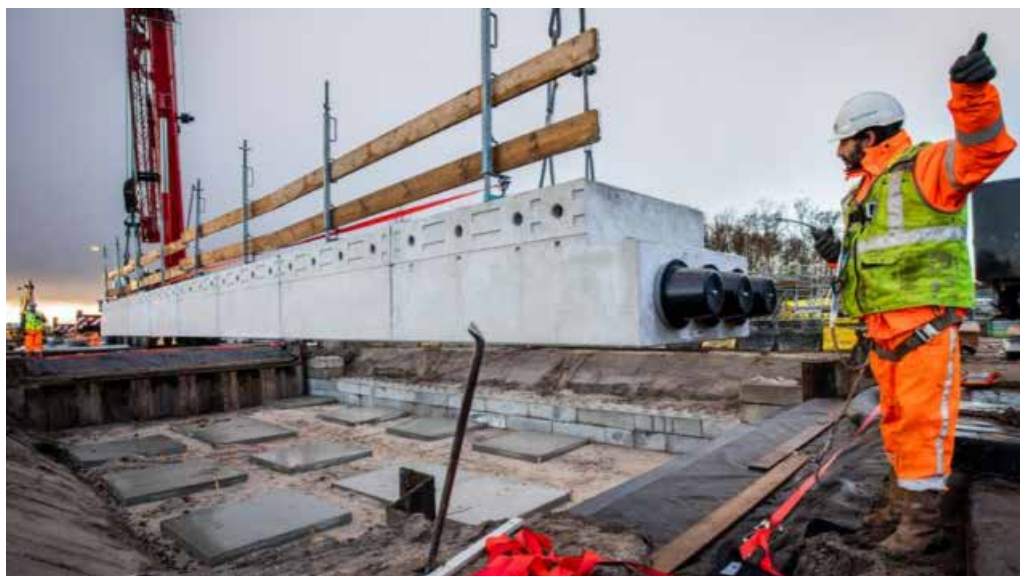
De bouw van het eerste circulaire viaduct.
