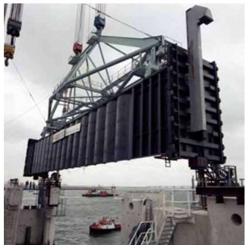
Bouw van de Oosterscheldekering, 1976-1986. Bron: Rijkswaterstaat
