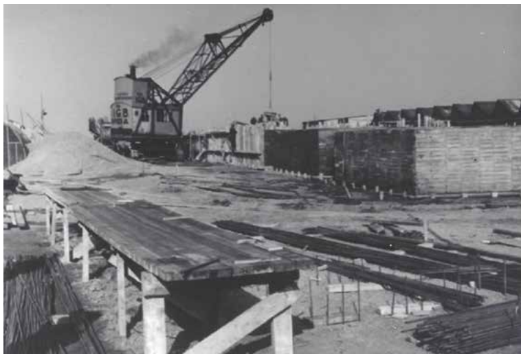
Bouw van caissons voor de Deltawerken in 1953.
